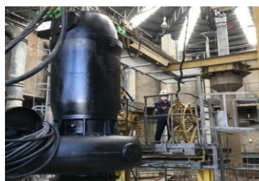
งานจัดหาและติดตั้งเครื่องสูบน้ำเสีย
