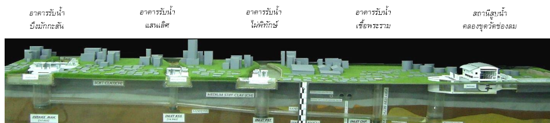
แผนการแสดงตำแหน่งอาคารรับน้ำ 4 อาคารและเส้นทางไหลของน้ำไปยังสถานีสูบน้ำคลองวัดช่องลม
