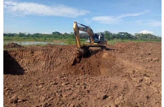
งานจัดเตรียมพื้นที่หน้างานและขุดบ่อพักน้ำ
