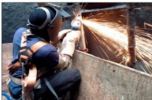
งานซ่อมเสาสของเครื่องสูบน้ำที่ชำรุด
