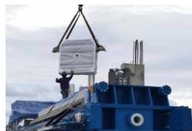
งานติดตั้งระบบกำจัดตะกอน
