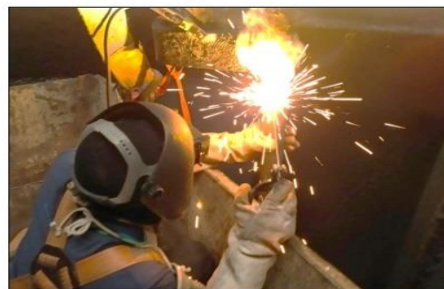
งานซ่อมเสาสของเครื่องสูบน้ำที่ชำรุด
