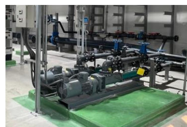
งานจัดหาและติดตั้งเครื่องสูบน้ำ
