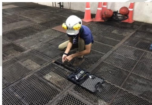
การตรวจวัดค่าปริมาณออกซิเจนใน ระบบเติมอากาศ
