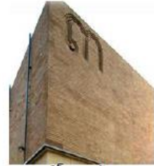
สตูดิโอ 3 : สักทอง พื้นที่สตูดิโอ 560 ตร.ม.
