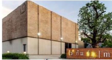
สตูดิโอ 2 : ทองหลาง พื้นที่สตูดิโอ 440 ตร.ม.
