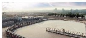
โรงผลิตก๊าซชีวภาพระบบ UASB และโรงไฟฟ้า 1.9 MW
