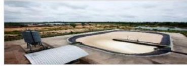
โรงผลิตก๊าซชีวภาพระบบ MUR (98,000 Nm 3 /วัน)
