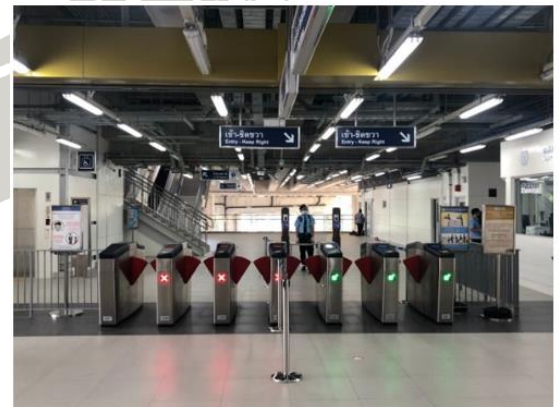
ติดตั้ง Gate Array and Push Gate (Concourse Level)
