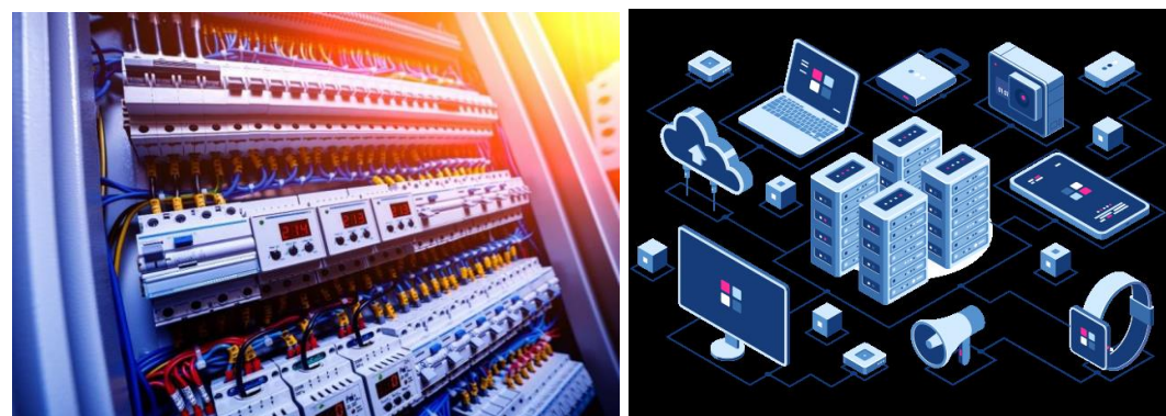
Figure 5: ตัวอย่างงานวางระบบโครงข่ายหลัก
