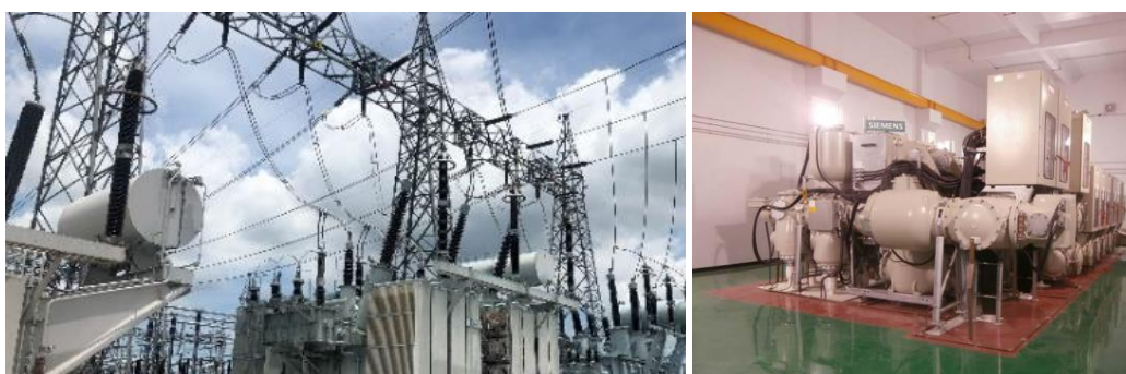
Figure 2: ตัวอย่างงานก่อสร้างติดตั้งสถานีไฟฟ้าย่อย
