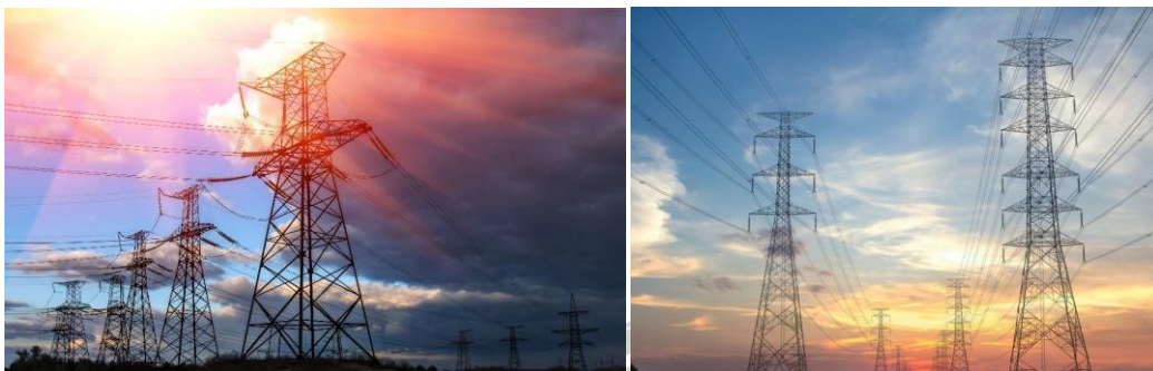
Figure 1: ตัวอย่างงานก่อสร้างสายส่งไฟฟ้าแรงสูง
