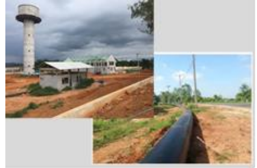
โครงการก่อสร้างขยายการผลิตน้ำประปา การประปาส่วนภูมิภาค พระปรัง จ.สระแก้ว
