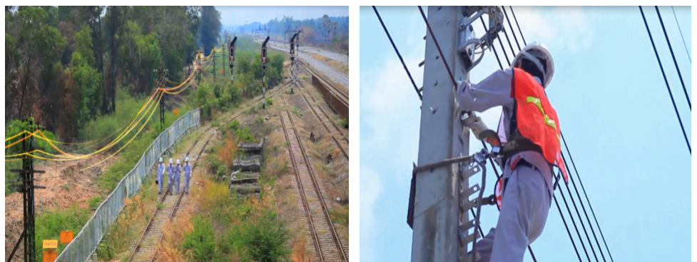
Figure 4: งานบริการติดตั้งโครงข่าย
